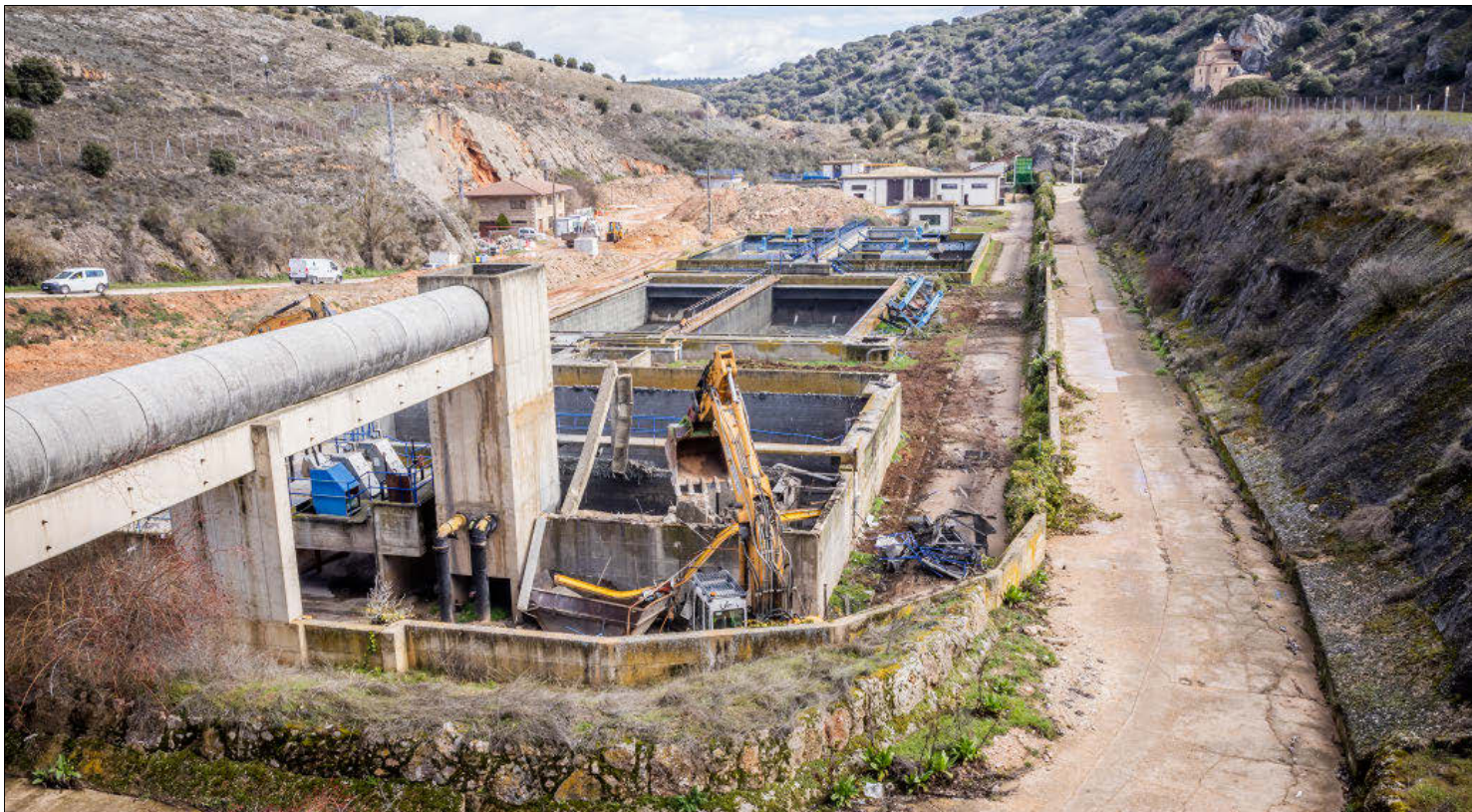
La maquinaria pesada actuando en uno de los extremo de la vieja depuradora de Soria. MARIO TEJEDOR
