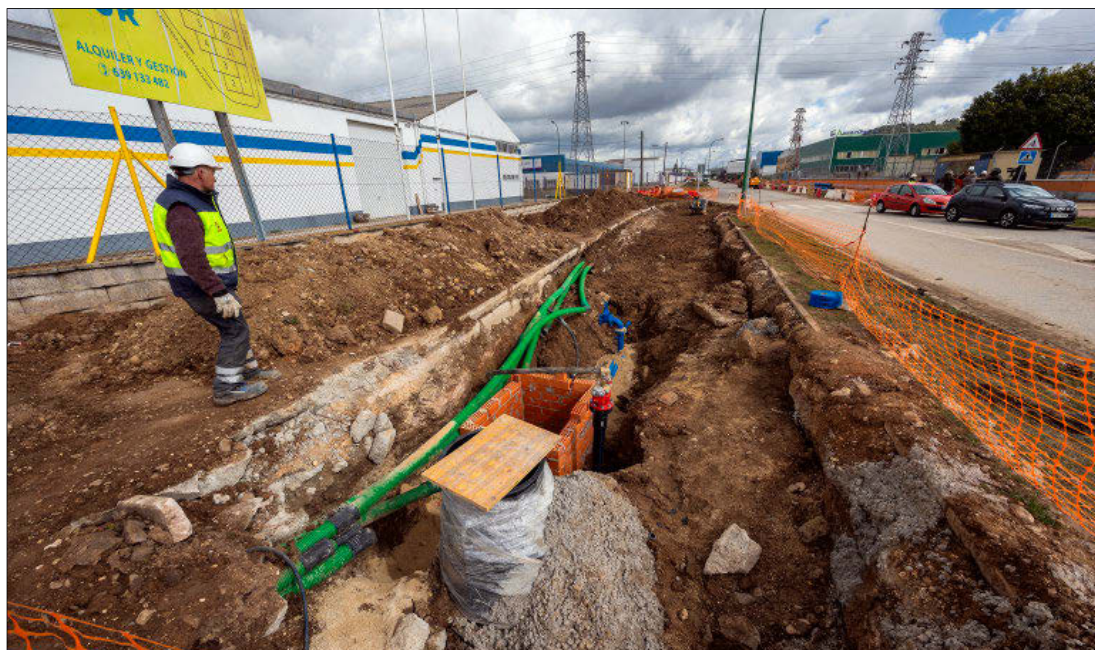
La calle Montes de Oca, en Villalonquéjar, está en obras para renovar las redes de agua. TOMÁS ALONSO
